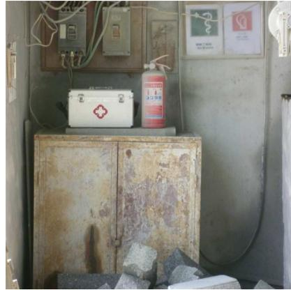
Sicherheitsschilder, Erste Hilfe-Kasten und Feuerlöscher, der Zugang ist jedoch durch Stein-schutt versperrt.
